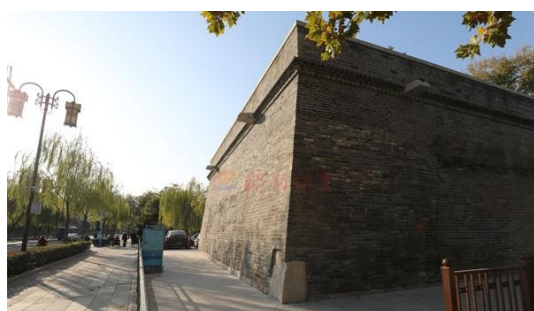
钟楼台基修缮后
