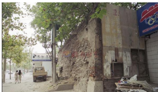
钟楼台基修缮前
