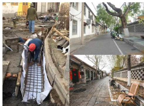
街巷泉渠整治
