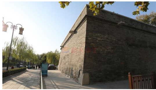
钟楼台基修缮后
