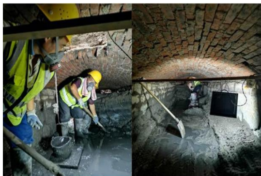
玉带河清淤、疏通及风貌整治
