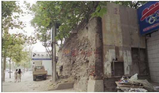
钟楼台基修缮前
