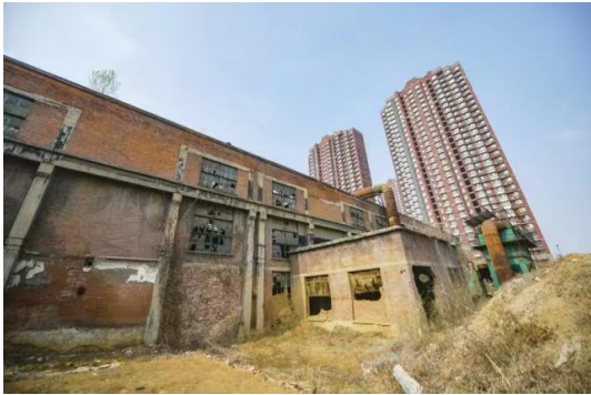
改造前的“二钢”老厂房
