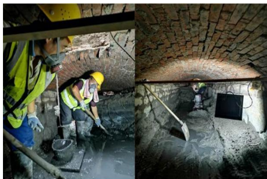
玉带河清淤、疏通及风貌整治
