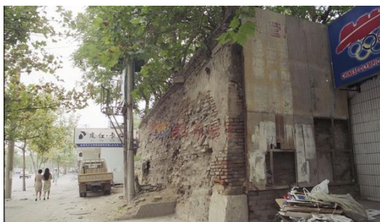
钟楼台基修缮前
