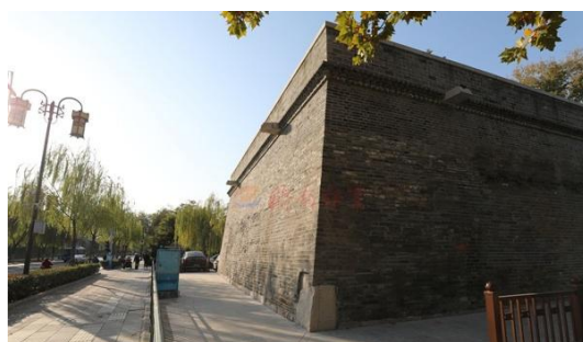
钟楼台基修缮后
