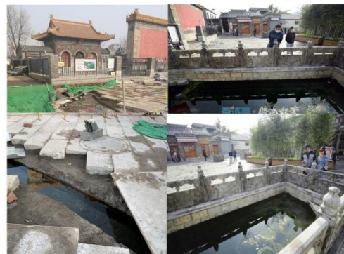
文庙南广场泉渠治理-重现梯云溪遗迹
