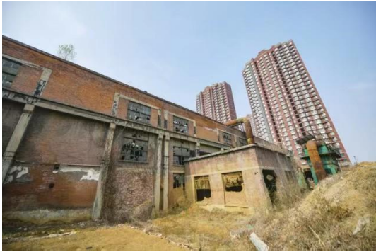
改造前的“二钢”老厂房
