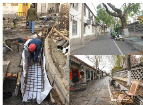
街巷泉渠整治
